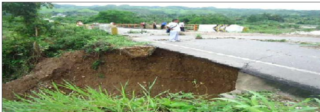
FIGURA N° 03.- SE VISUALIZA LA CARRETERA SACANCHE - SAPOSOA, LA CUAL SUFRIÓ LA SOCAVACIÓN DE SU ESTRUCTURA A LA ALTURA DEL PUENTE SACANCHE, DEBIDO A LOS DESBORDES DE LA QUEBRADA OCURRIDO EN AÑOS ANTERIORES.
